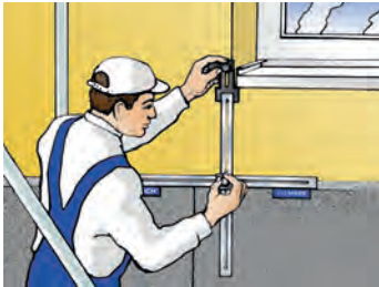
2. Ausrichten der Schablone auf die Fensterbankunterkante
