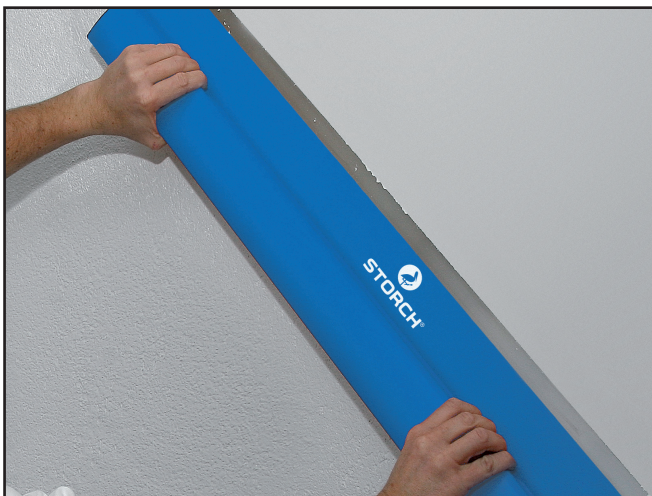
Zeitsparendes Glätten aufgespritzter Putze und Spachtel.
